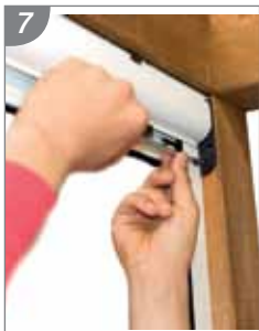
7 fissare le viti sulla testata negli appositi fori fix the screws into the holes in the cap
